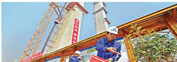
杨泗港长江大桥工地上工人在给苗木浇水。 记者俞松 摄
